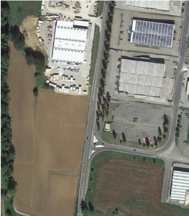
Figura 31 Attuale incrocio di accesso all'area industriale della Ferrantina
