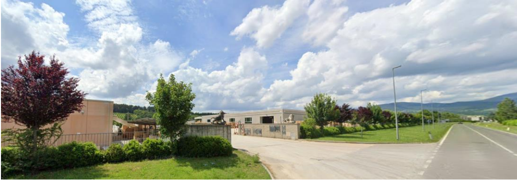
Figura 4 Area Scart. Vista dello stabilimento attuale
