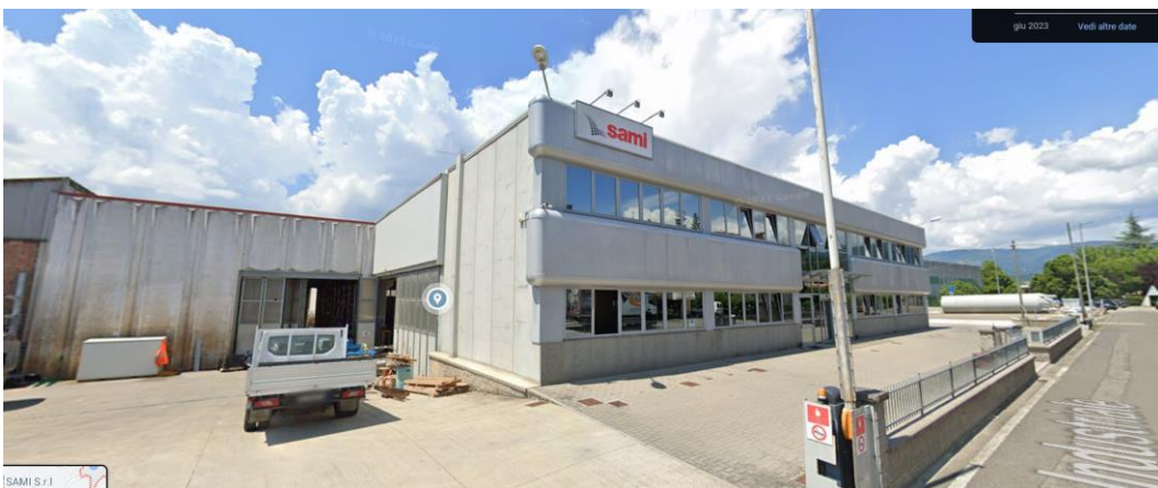
Figura 6 Vista dello stabilimento principale non oggetto di demolizione
