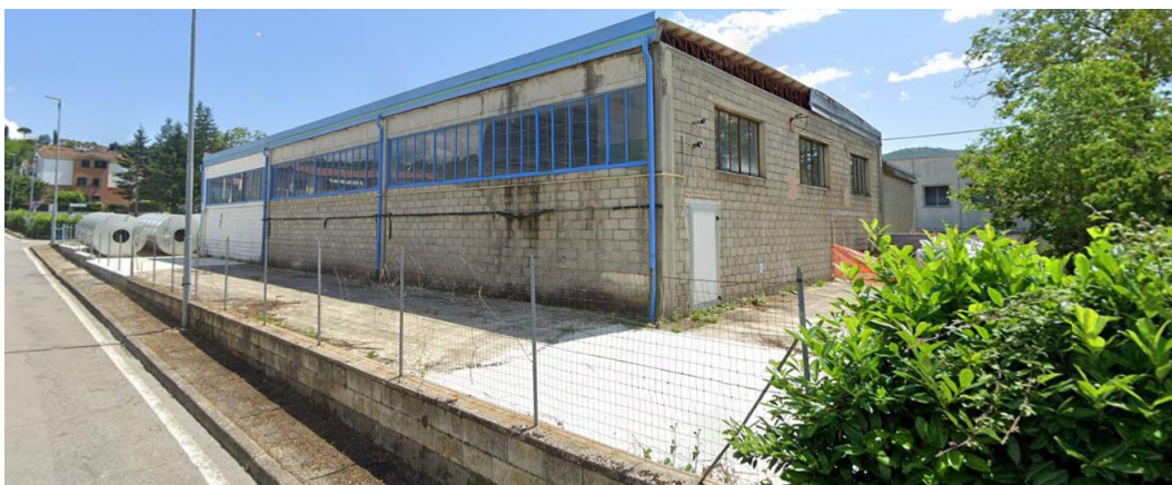
Figura 7 Edificio oggetto di sostituzione edilizia.
